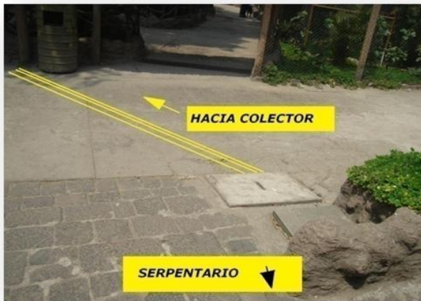
Caja de drenaje Fuente: elaboración propia
