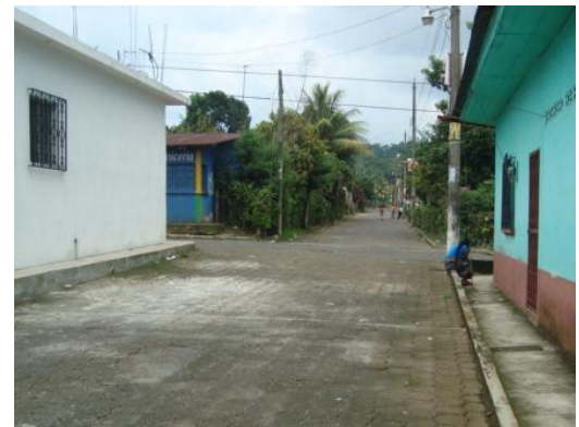
Casas construidas de mampostería
