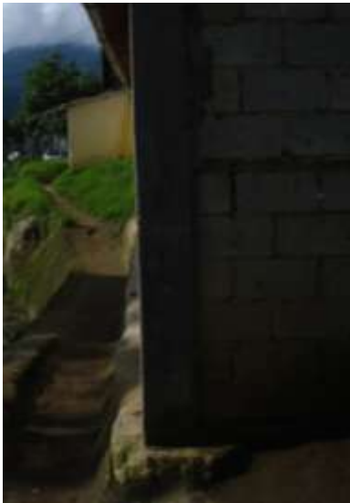
1. Muros de la Actual capilla, se observan block y concreto reforzado.
