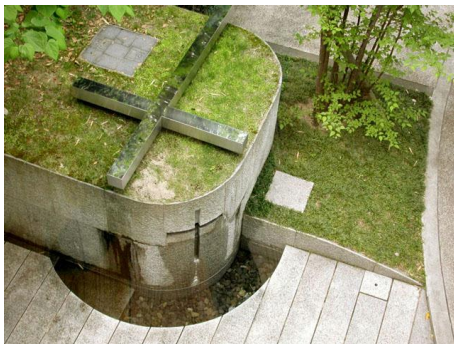
IMAGEN1: IGLESIA DE LA LUZ VISTA EN PLANTA DE LA IGLESIA. FUENTE http://img136.imageshack.us/img136/1589/laiglesiadelaluzje2.jpg
