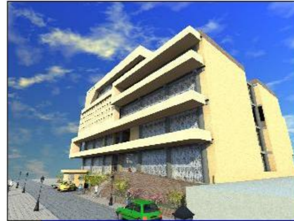
APUNTE EXTERIOR FACHADA
