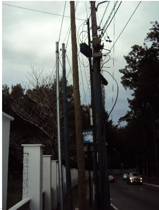
Fotografía: 11 en la imagen se observa que en el perímetro del terreno se encuentran ubicados los cableados de luz y teléfono. Fuente: Héctor García
