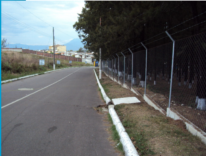
Fotografía: 12 en la imagen se observa que en el perímetro del terreno se encuentran los drenajes y tragantes para recolectar las aguas de las calles. Fuente: Héctor García
