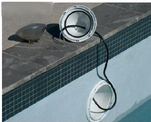
Imagen del cambio de una lámpara sumergible
