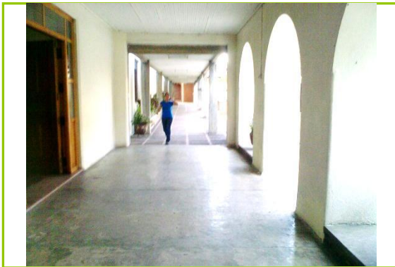
Foto grafía 12. Pasillo que conduce a la Capilla Mayor
