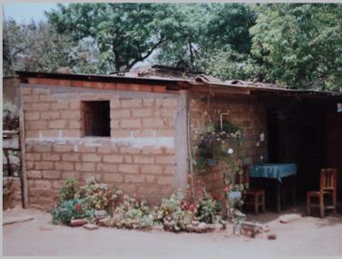
**FOTOGRAFÍA No. 127:** Vivienda de una familia de escasos recursos. Posterior al terremoto se implementa el uso de adobe + columnas de concreto + lamina.
