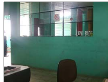
El color permanece en todo el edificio Municipal, tanto interior como exterior.
