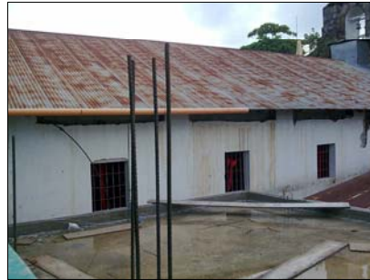
LATERAL DE IGLESIA COLINDANCIA CON MUNICIPALIDAD
