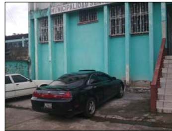
② Ingreso a la Municipalidad de Santa Cruz Muluá, con un área de parqueo para 4 vehículos.
