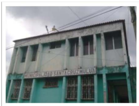
Fotografía No. 6 Edificio Municipal, fachada lateral, Fuente Propia
