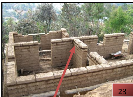
Construcción de una vivienda utilizando el sistema constructivo de muros de adobe sin refuerzo. Aldea Agua Tibia, Comitancillo, San Marcos.
