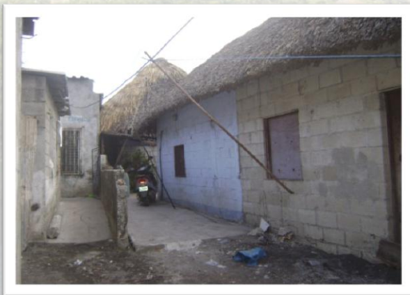
FOTOGRAFIA 7: ALDEA BUENA VISTA VIVIENDA DE MAMPOSTERIA Y TECHO DE PALMA
