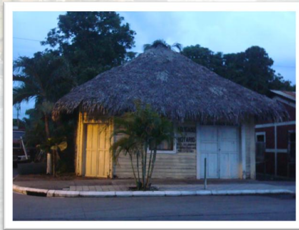
FOTOGRAFIA 5: VIVIENDA TRADICIONAL EN IZTAPA CASCO URBANO FOTOGRAFIA: EDICION PROPIA
