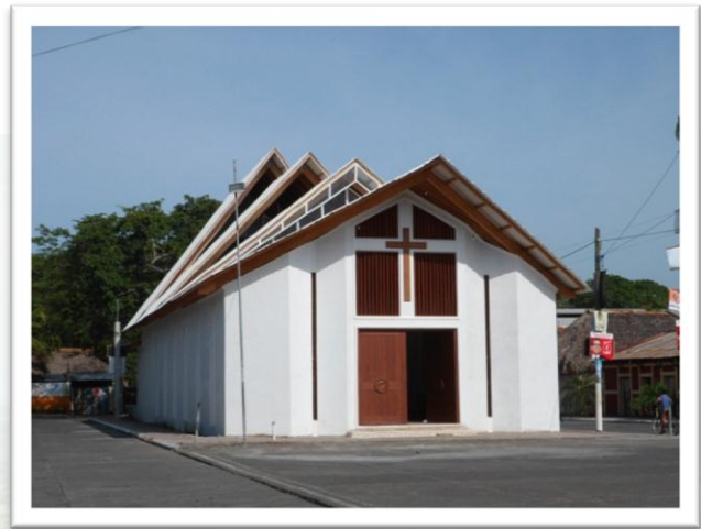
FOTOGRAFIA 13: IGLESIA CATOLICA CASCO URBANO
