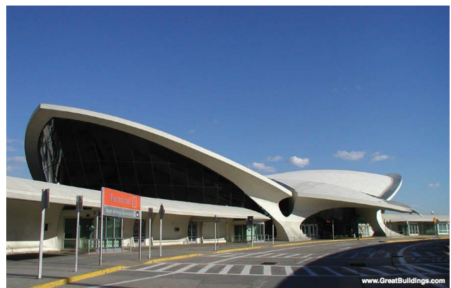
Fotografía No. 38. Aeropuerto TWA, terminal JFK. Diseñado por Eero Saarinen. Fuente: www.greatbuildings.com
