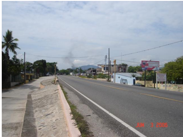
Foto 23. Pavimentación utilizada en la vía principal en la Ruta CA-10. Fuente: Propia.
