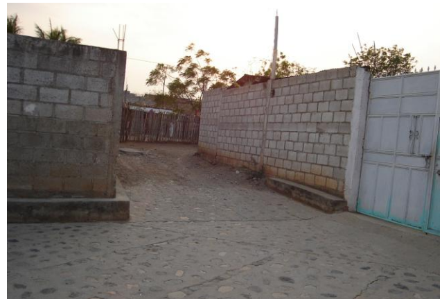
Fotografía 22. Calle empedrada en la Aldea Chispán, Estandzuela. Fuente: Propia.
