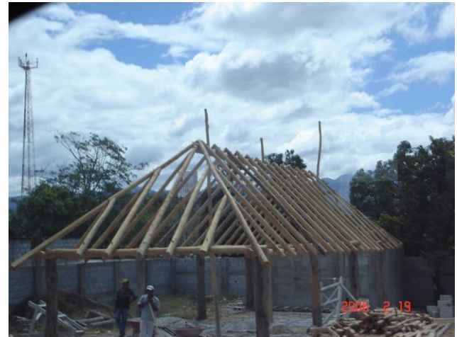
Foto 24. Construcción de local comercial con sistema estructural de palo rollizo y palma. Fuente: Propia.
