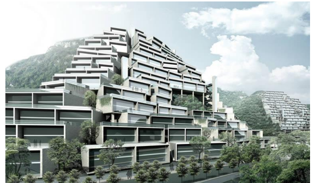
Fotografía No. 42. Complejo residencial en Liuzhou, China. MRVDV. Fuente: www.urbanity.blogsome.com
