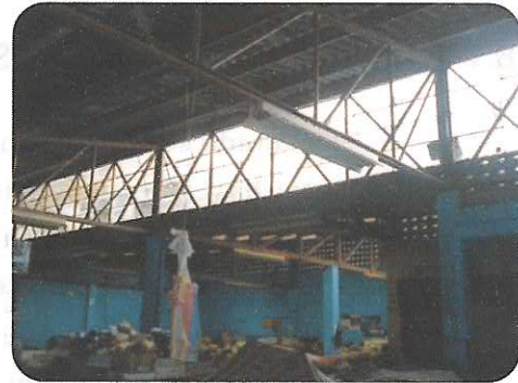
Fotografía: No.2 Estructura e iluminación interior
