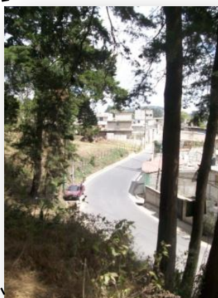
Servicios básicos sobre calle principal
