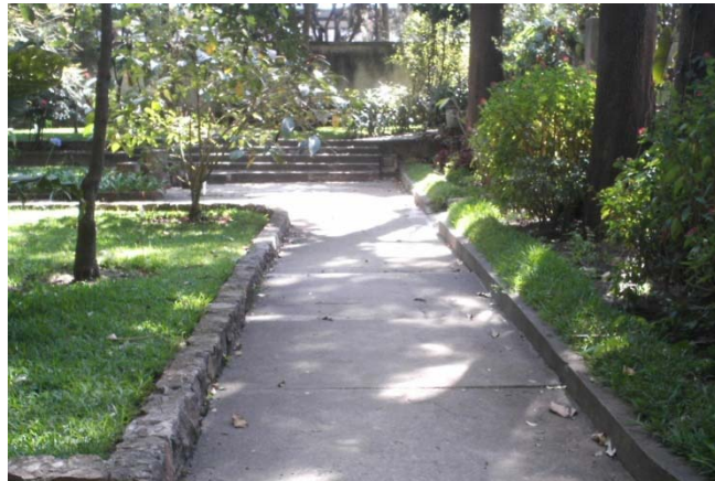
24. Fotografía, de manejo de desniveles y terrazas, y piso de cemento fundido en lozas. De un metro de largo.
