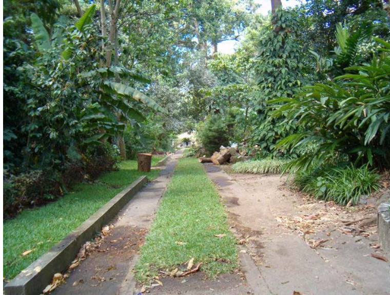
28. Visual desde la puerta se denota la rodadura elaborada para el acceso de vehículos, la cual es aun utilizada de acuerdo a las necesidades del Jardín.
