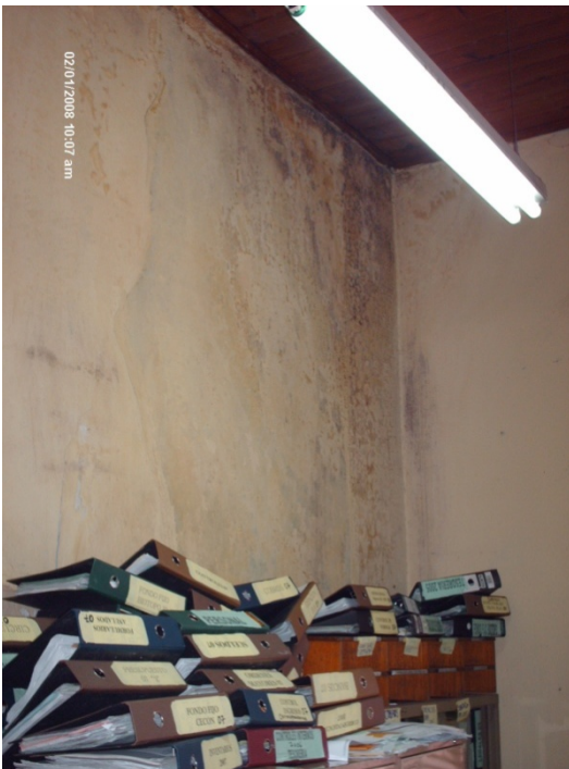
Fotografías 7, 8, 9 - Daños ocasionados por la humedad en paredes y el machiambre que está presente en todo el edificio.
