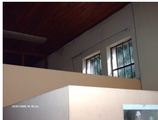
Fotografías 7, 8, 9 - Daños ocasionados por la humedad en paredes y el machiambre que está presente en todo el edificio.
