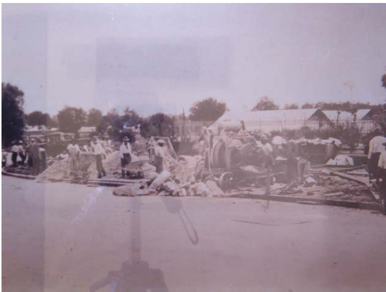
Foto9. Avenida La Reforma Fotografía de trabajos municipales alrededor de los años 60. Al fondo puede observarse la reja y otras estructuras que no competían con la importancia del Jardín no habían edificios.
