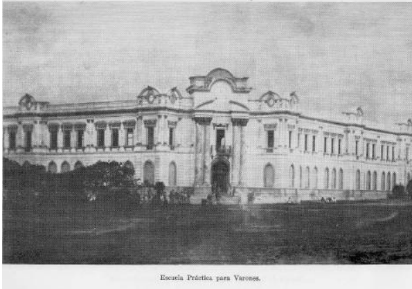
Fotografía 1. Escuela Práctica de Varones 28
