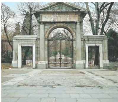
Fotografía 7 VISTA DEL INGRESO INGRESO
