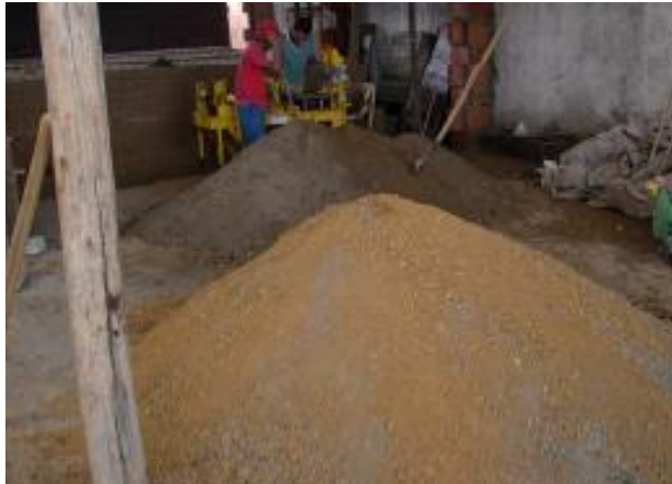
Imagen No. 42. Preparación Mezcla Seca y Húmeda del Suelo.
