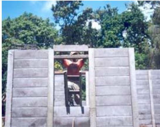
Imagen No. 7. Sistema Prefabricado Bloque Panel.
