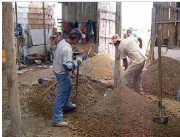
Imagen No. 41. Preparación Mezcla del Suelo.
