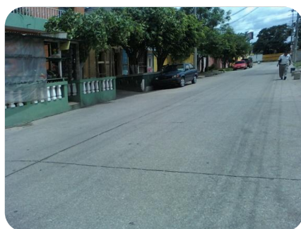
Foto No. 6 FOTOGRAFIA PROPIA. 2011 en la colonia se encuentra una planta de luz eléctrica.
