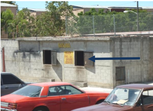
Fotografía 3.6 Fuente: Elaboración Propia 2,011 Para el área de basura se cuenta con contenedores ubicados en cuartos los cuales están en la parte de servicio en la parte trasera.
