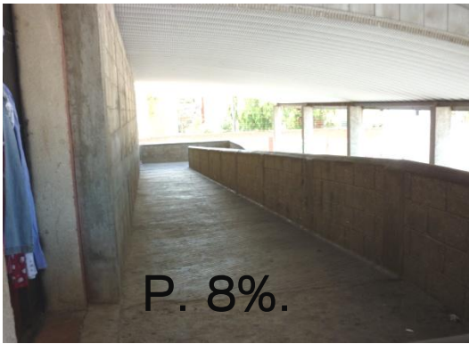
Fotografía 3.5 Fuente: Elaboración Propia 2,011 El buen planteamiento de este mercado se ve ya que posee rampa para subir al segundo nivel, teniendo esta la pendiente mínima requerida.
