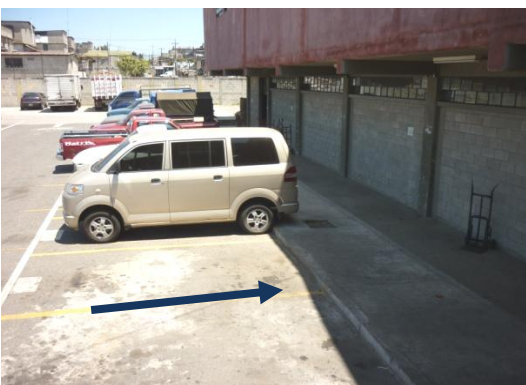
Fotografía 3.7 Fuente: Elaboración Propia 2,011 El área de descarga se cuenta con un desnivel en el cual se pueden retirar los vultos cómodamente de los vehículos de tamaño regular que pueden llegar descargar.
