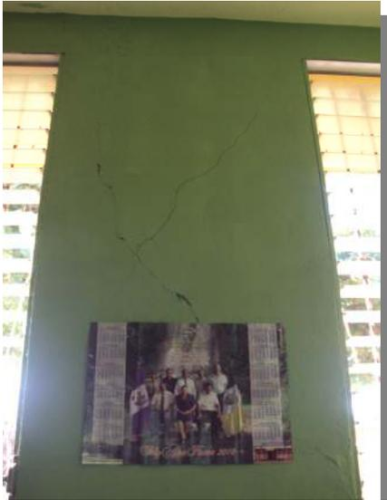
Grietas en diferentes direcciones, en el 95% de los muros del edificio municipal.
