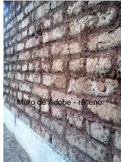
Grafica: Muro de Adobe - relleno Fuente: Fotografía Propia.
