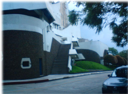
Fotografía: Fachada Poniente
