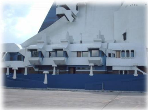
Fotografía: Fachada Oriente, vista a Ingreso de artistas
