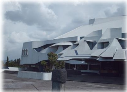
Fotografía: Fachada Norte
