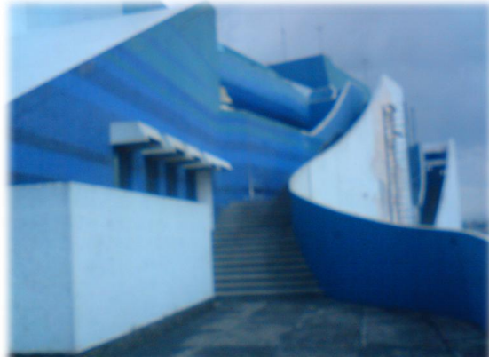
Fotografía: Vista de gradas de servicio
