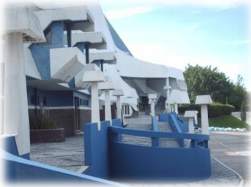
Fotografía: Fachada Oriente
