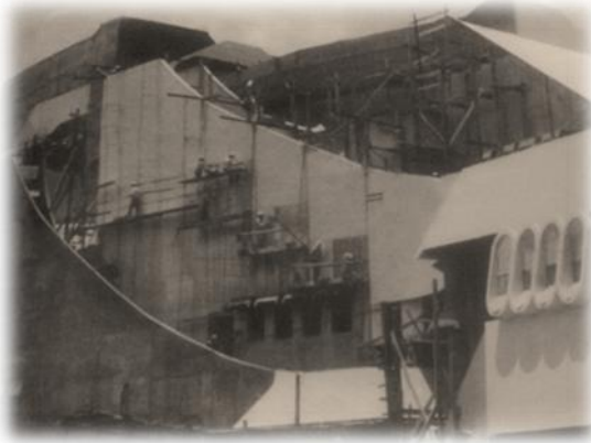
Fotografía 15: Vista de la construcción de la fachada oriente.
