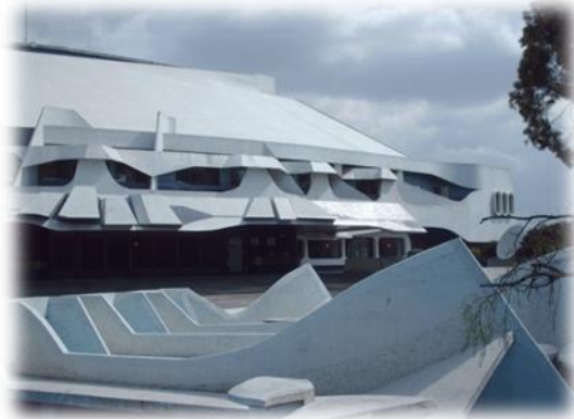
Fotografía: Fachada Norte
