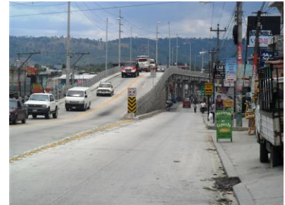
Imagen No. 12 Paso a desnivel Chimaltenango Tomada por: Winston Paul Texaj H.
