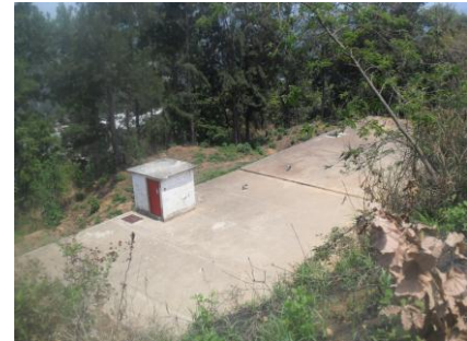
Imagen No. 22 Tanque de agua que abastece de agua alas zona 4, 2, 1. Del municipio de Chimaltenango Tomada por: Winston Paul Texaj H.
