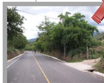
Fotografía 2.13. Carretera RD-6 e ingreso al terreno. Fuente: Propia.
