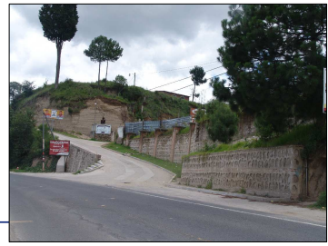
Fotografía No. 79 Acceso al terreno. Fuente: Propia.
