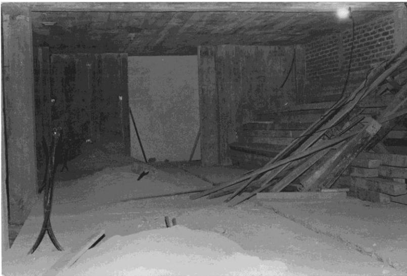
**Trabajos interrumpidos en la década de los años noventa, nótese el intento de introducir tuberías rompiendo los elementos previamente fundidos. Evidencia de la falta de planificación y de supervisión del proyecto**
