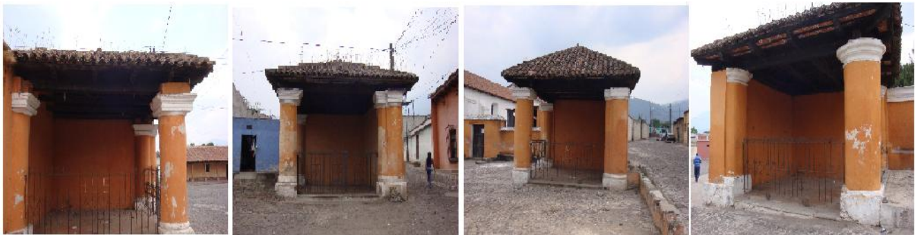
Fotografía 47: Estado Actual Capillas Posas
