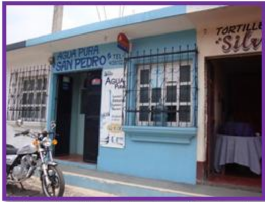
Fotografía 30: Contaminación visual instalada
