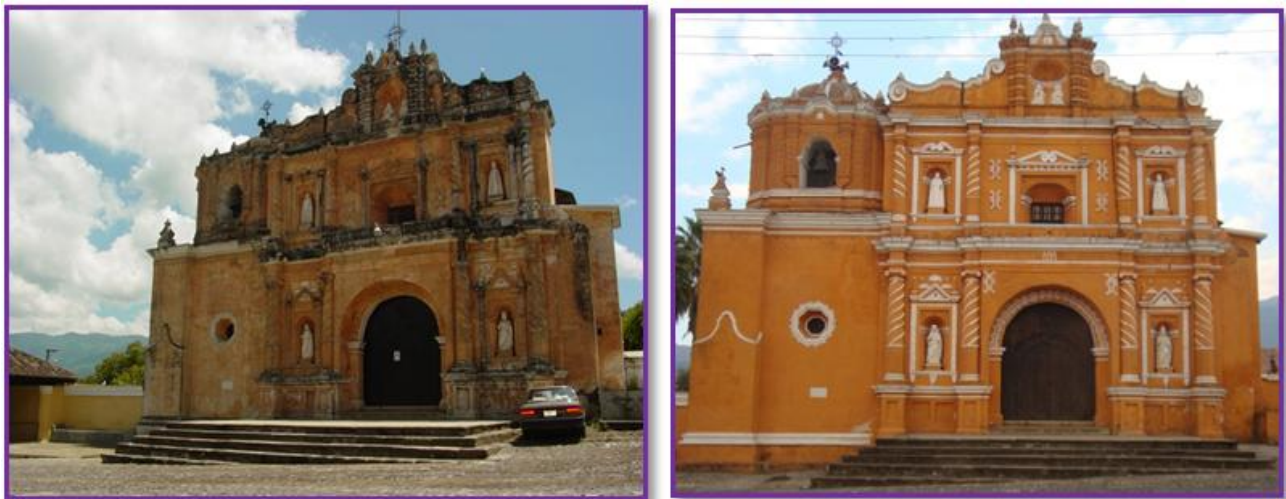
Fotografía 45: Estado anterior a la restauración del 2009 de la fachada de la iglesia y estado actual de la misma.
