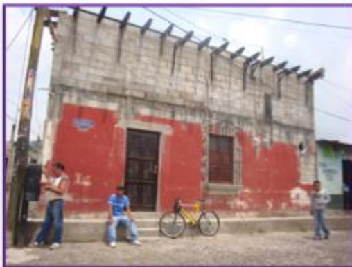
Fotografía 22: Construcción discordante frente a la plaza
