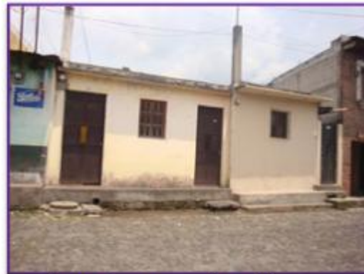
Fotografía 23: Construcción con elementos asimétricos
