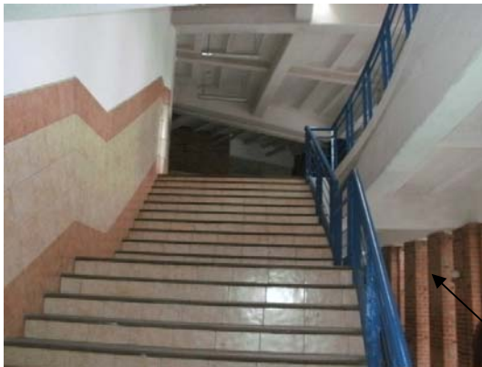
IMAGEN 52,53, FOTOGRAFÍAS MODULOS DE GRADAS COLEGIO KINAL
