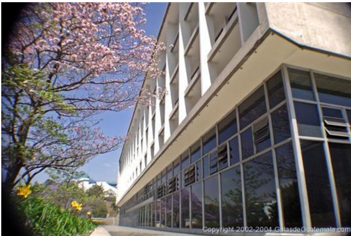
ILUSTRACIÓN 10 APUNTE DE LA MUNICIPALIDAD DE GUATEMALA DONDE SE APRECIAN LOS PARTELUCES Y LA VENTILACIÓN SUPERIOR (GALAS DE GUATEMALA© 2002-2004)
