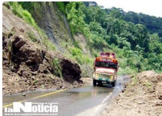
FOTOGRAFÍA 8 DERRUMBE RUTA REFORMA-COATEPEQUE (LA NOTICIA, 2008)
