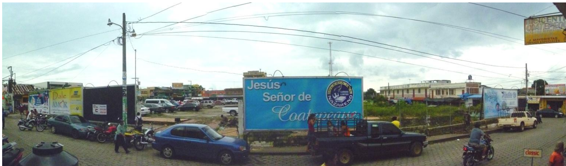
ILUSTRACIÓN 24 VISTA PANORÁMICA DEL TERRENO DESDE LA 1 AVENIDA. SE OBSERVA QUE EL ESTADO ACTUAL DEL TERRENO ES UN PARQUEO MUNICIPAL, LAS VALLAS PUBLICITARIAS RODEAN EL SITIO (IMAGEN PROPIA AGOSTO 2011)
