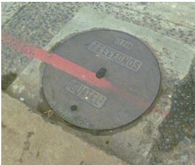
ILUSTRACIÓN 19 TAPADERA TÍPICA DE TELÉFONOS DEL ANTIGUO GUATEL, AHORA TELGUA (IMAGEN PROPIA AGOSTO 2011)
