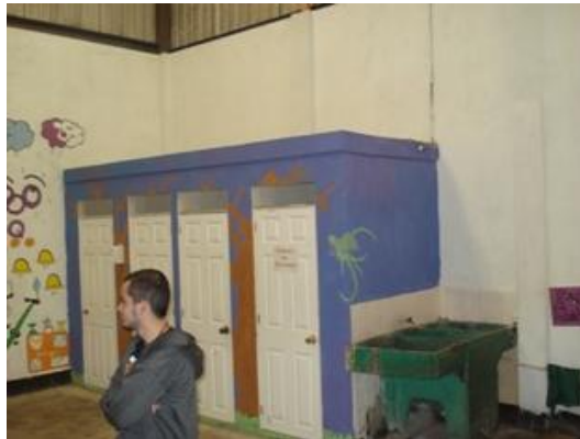
Área de baños
