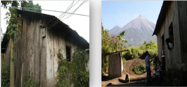
Figura 15. Viviendas en muy alta vulnerabilidad
