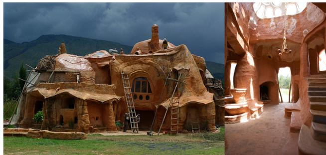
**FOTOGRAFÍA 4** - Del Arq. Octavio Mendoza, esta casa construida completamente de arcilla, posteriormente expuesta a una temperatura alta, lo que convierte el elemento arquitectónico en un solo ladrillo, impermeable al agua, resistente a los daños de los terremotos, y agradablemente fresca en climas cálidos. Fuente: www.topboxdesign.com
