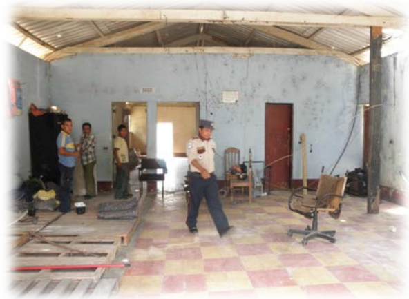
Fotografía No. 15, Edificio de Reacción del COE de Zacapa Fuente: Elaboración Propia
