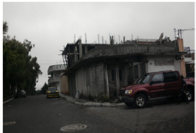
FOTO NO. 30 Materiales de Construcción. Fuete: Herbert González Yes.
