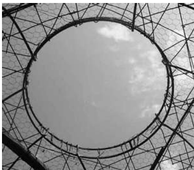
Ilustración 12 Armadura de ferrocemento
