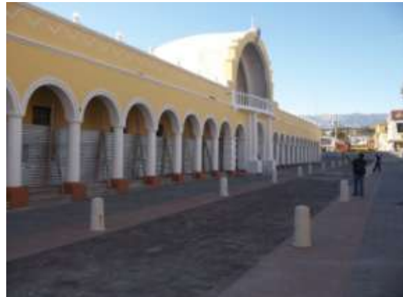
Fotografía 2,Edificio Municipal, Zona 1, Huehuetenango, Fuente: Propia
