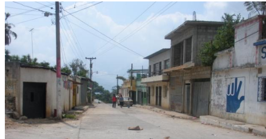
Fotografía 3 VIVIENDAS Fuente: Propia
