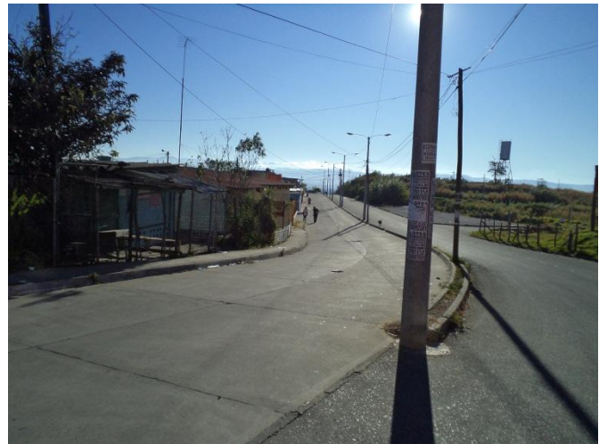
FOTOGRAFÍA No.13: Boulevard de ingreso (3ra.Avenida) con alumbrado público recién instalado. Colonia La Ceiba. Fuente: Elaboración Propia. Diciembre 2011.
