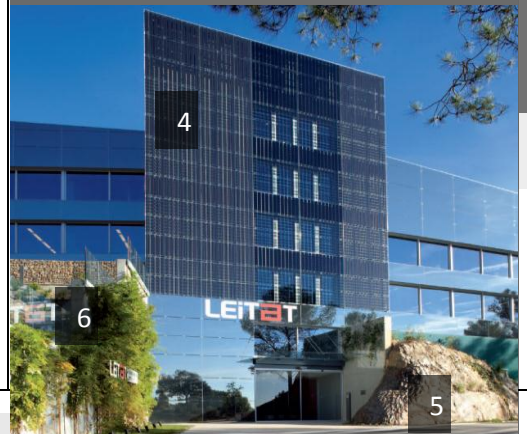
Fotografía No. 49 Fuente: http://www.b01arquitectes.com Materiales de la fachada principal
