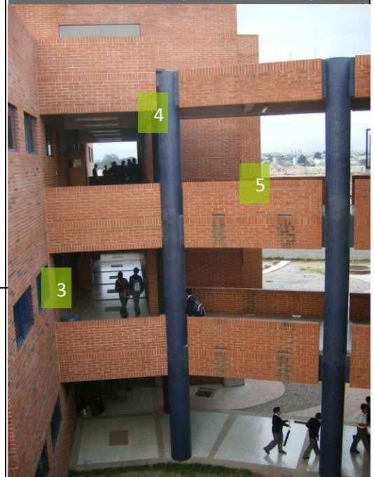
Fotografía No. 55 Fuente: http://www.b01arquitectes.com Soportes verticales (columnas) corredores aéreos.
