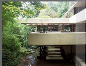
Fotografía No. 25 Losas en voladizo y gradas.
