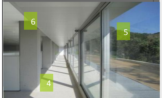
Fotografía No. 47 Fuente: http://www.b01arquitectes.com Vista de la estructura interior.
