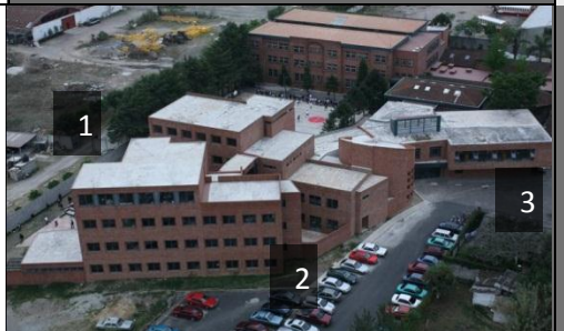
Fotografía No. 52 Fuente: http://www.facebook.com/kinal.gt Vista del Exterior
