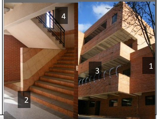
Fotografía No. 56 Fuente: http://www.b01arquitectes.com Acabados de gradas, fachaletas y barandas exteriores..
