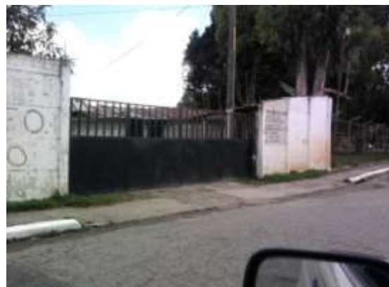
Imagen 30: Bodega de materiales Fuente: Propia
