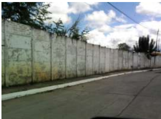
Imagen 29: Bodega de materiales Fuente: Propia
