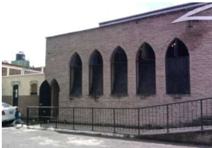
Imagen 2: Vista lateral, ingreso secundario, Iglesia Sta. María Fuente: Propia
