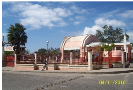
F2. 3ª.av. y 3ª calle esquina parque
