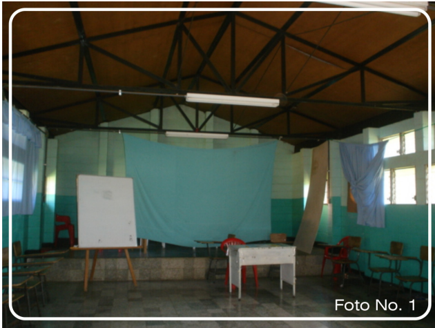
Fotografía No. 1: Salón de usos múltiples o área de Educación ambiental. Se observa que no es un espacio apropiado para impartir este tipo de información.
