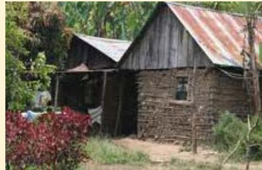
El bajareque es un sistema constructivo que consiste en una armazón o estructuras de caña brava o madera no aserrada forradas con lodo.
