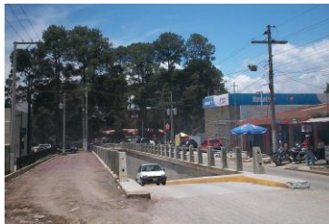
Fotografía No. 17 Principal conexión del paso a desnivel hacia 9na. Calle zona 9.
