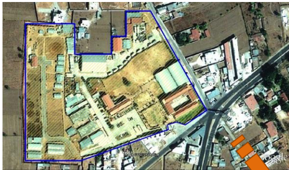
Fotografía No. 6 Oficinas Centrales INTERVIDA Guatemala Fuente: Google Earth 2010.
