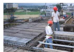
Fotografía No. 35. Fundición de losa
