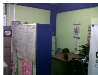
Fotografía No. 2 Altura de cubículos permite el paso de ondas sonoras / Fuente: archivo propio
