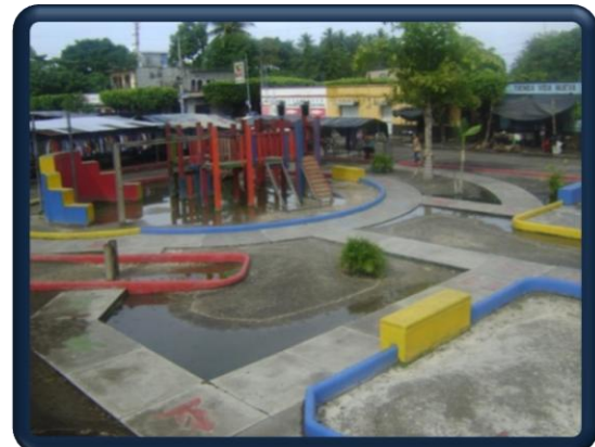
Véase la acumulación de agua en el área de juegos en época de invierno. Fotografía No. 22. Autor: Elaboración Propia
