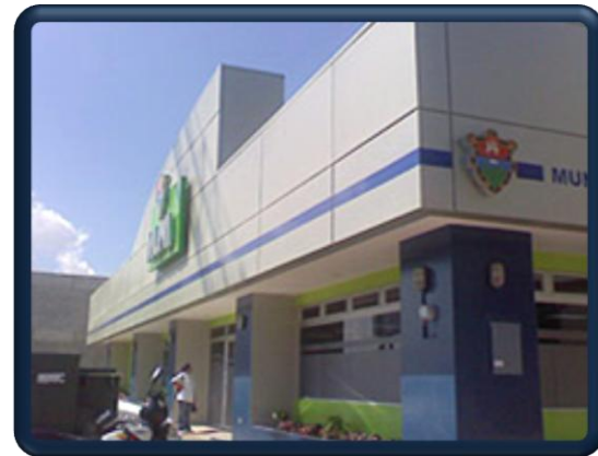
Véase el uso de estructura reticular. Fotografía No. 15. Autor: Elaboración Propia
