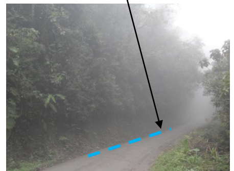
Tubería de Agua Potable
