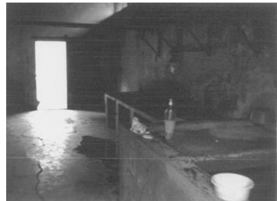
INTERIOR DEL RASTRO AREA DE DESTACE Y PILA
