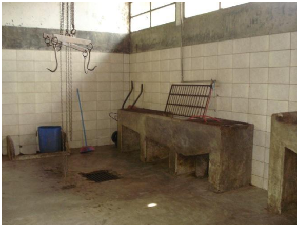
PILETA PARA LAVADO DE VÍSERAS
