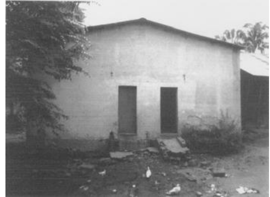
FACHADA POSTERIOS AREA DE DEPOSITO DE DESECHOS
