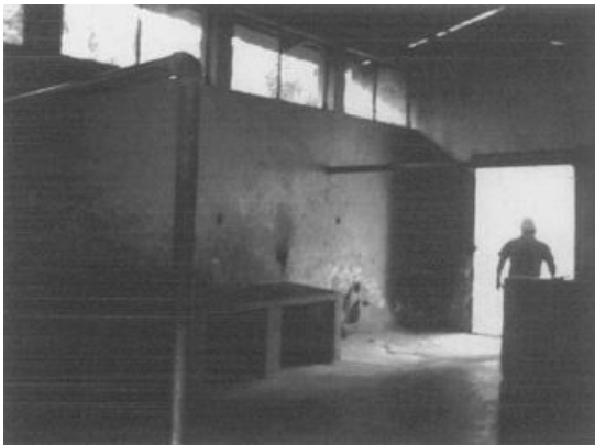
INTERIOR DEL RASTRO COLGADOR Y ÁREA DE DESTACE
