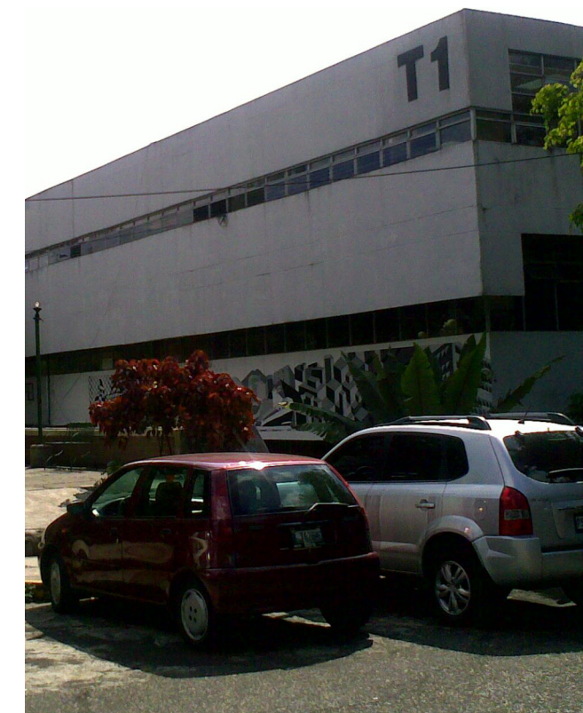
Toma lateral [Edificio T1]. Recuperado de http://commons.wikimedia.org/wiki/File:Edificio_T1_UCAS.jpg
