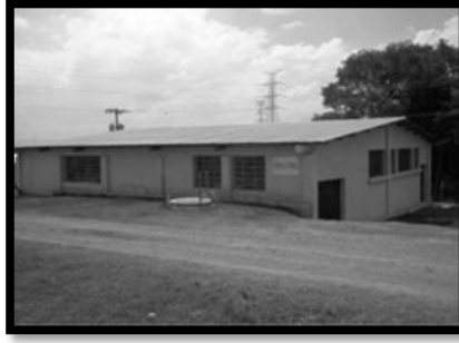
EDIFICIO EL RASTRO
