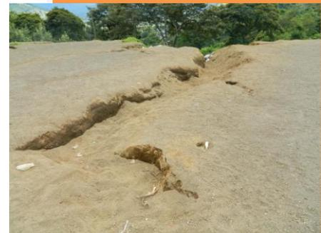
Ya colindante al caminamiento la pendiente es brusca e irregular causada por las lluvias. En esta área se recomendará realizar un muro de contención para seguir evitando el deslave del terreno y maximizar
