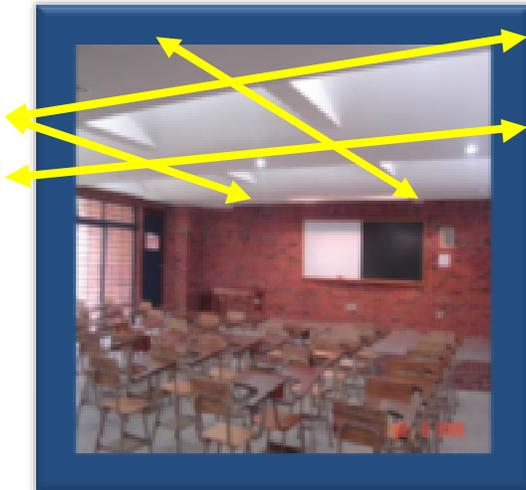
SU ESTRUCTURA RADICA TRAVÉS DE MARCOS ESTRUCTURALES DE PROPORCIÓN RECTANGULAR, FORMADO POR COLUMNAS Y VIGAS, Y ESTA A SU VEZ COMPLEMENTA SU RIGIDEZ CON LOSAS NERVURADAS
